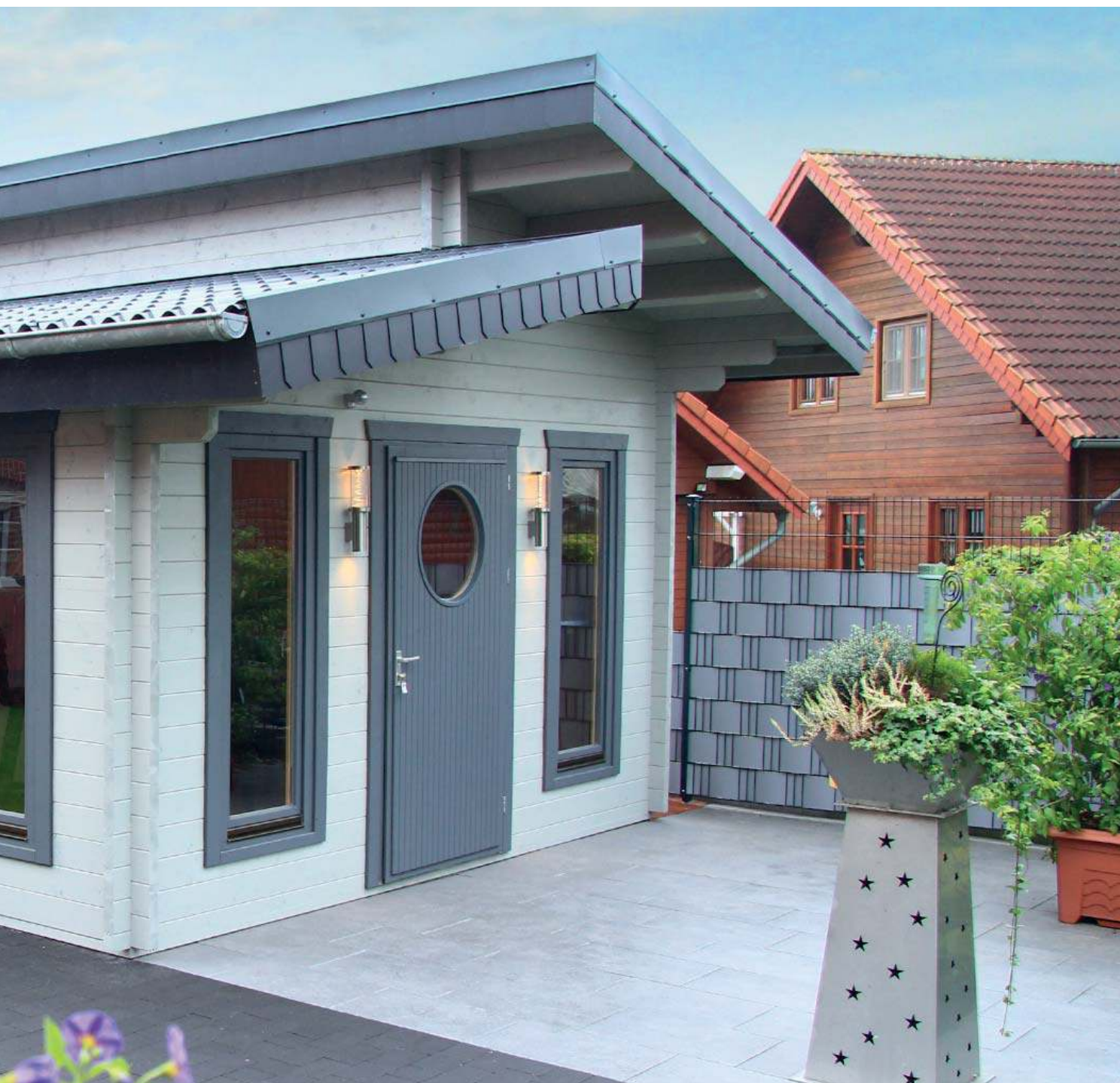
Construction en madriers
