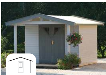
avancés de toit
