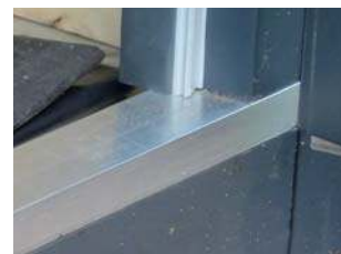
Semelles de porte avec couverture en acier fin ou seuil en aluminium possible en option
